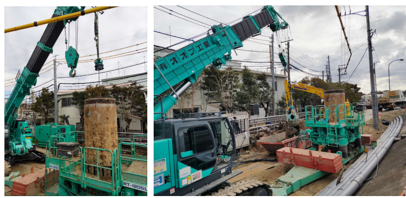
2 大型クレーンによる土壌改良が行われている
